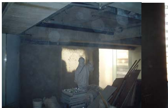
圖 13 以噴覆式制振材改善玻璃帷幕表面振動量
